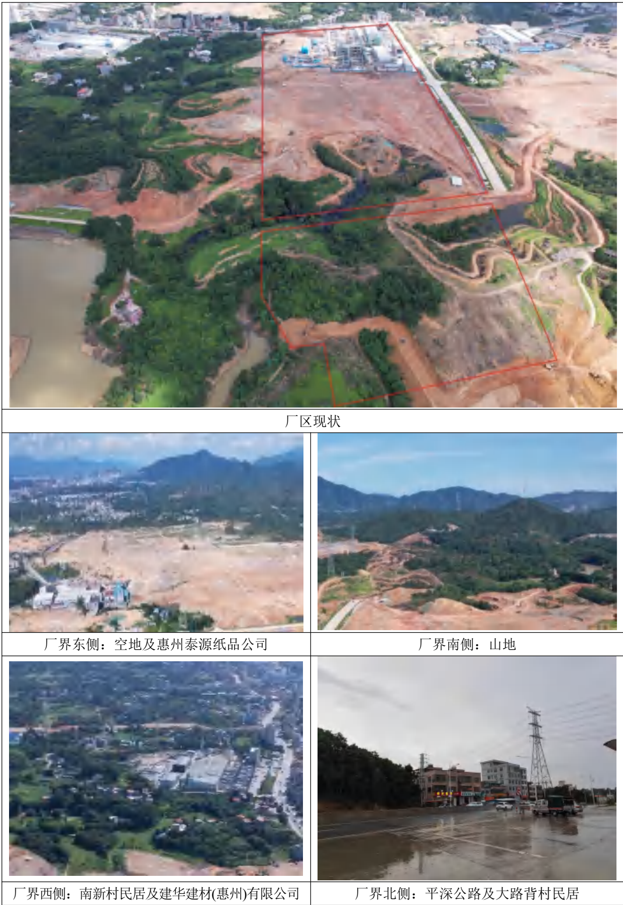
图 3.1-2 厂区现状及四至照片
