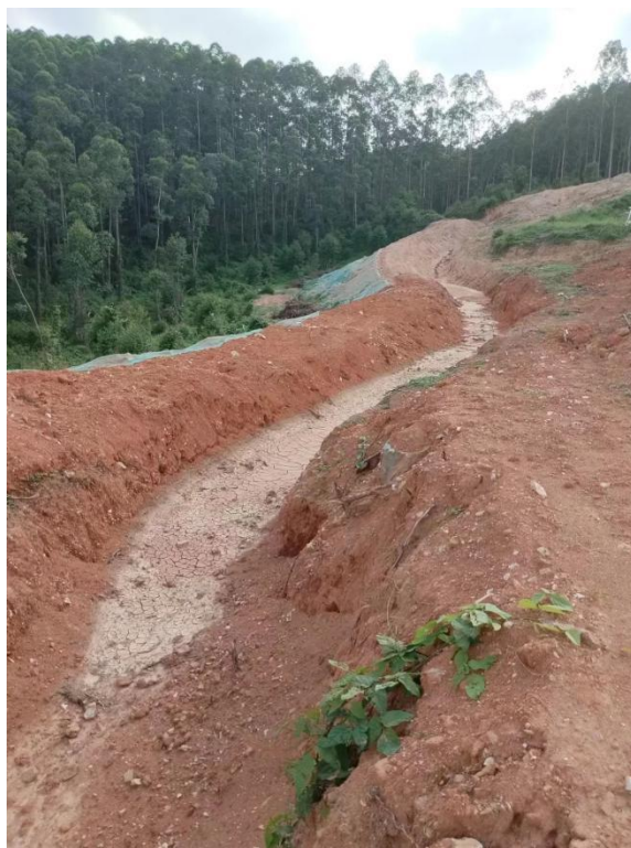
南面项目边界处导流沟及篷布覆盖
