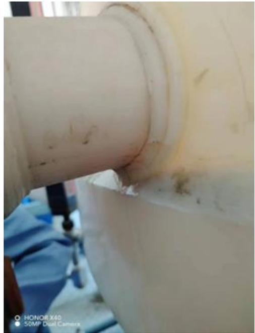
循环水站加药间缓蚀剂罐（跑冒滴漏）
