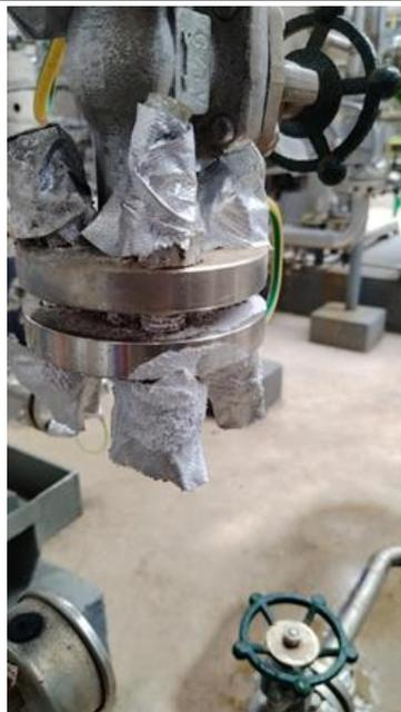
制氢装置区的碱液计量泵（跑冒滴漏）
