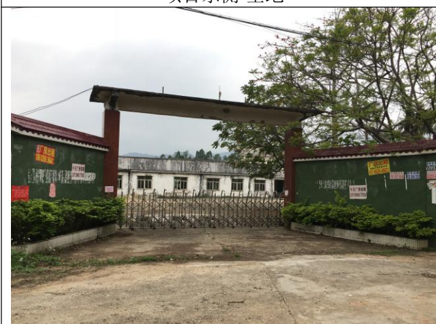
项目西侧-空厂房
