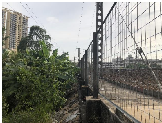
图 2.2-8 京九铁路路基
